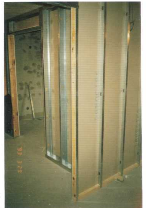
...och förstärkningar runt dörrar.
