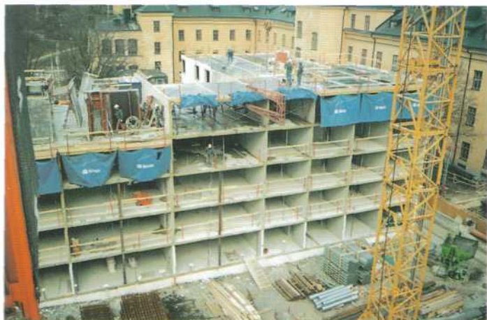
Stomcykeln gick runt på 3 trapphus i stöten.
