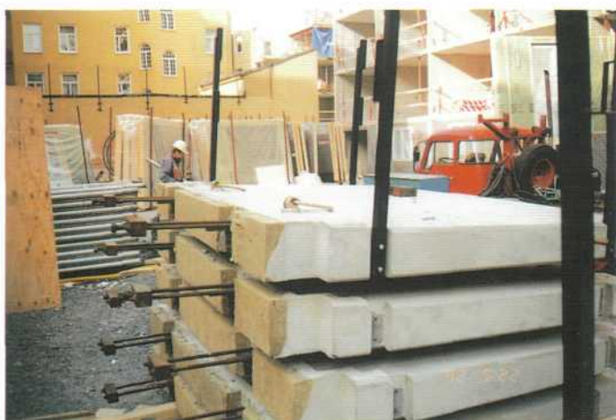
Balkongplattor levererade. Skyddsräckesstolpar monterade.
