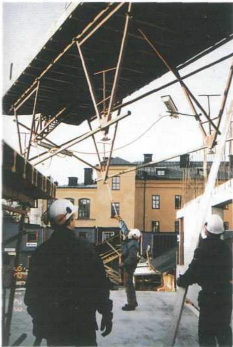
Formbord tas emot. Infravärmen monterad.
