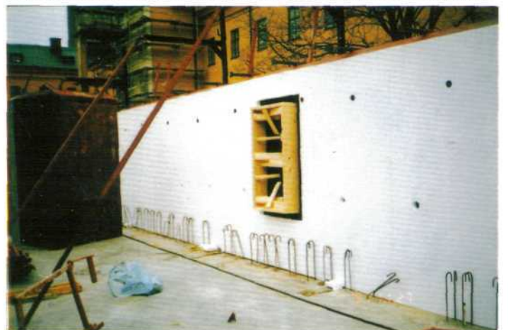
Inåtsträvad ytterväggsform. Ingjuten cellplastisolering. Observera blivande betongramen kring fönstersmygen. Underlättar montage av fönstret som ju alla arkitekter vill ha så långt ut som möjligt.
