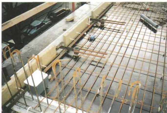
Ingjutningsgods före valvgjutning.
