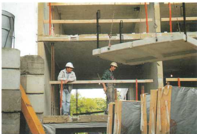
Balkongplattor levererade. Skyddsräckesstolpar monterade.
