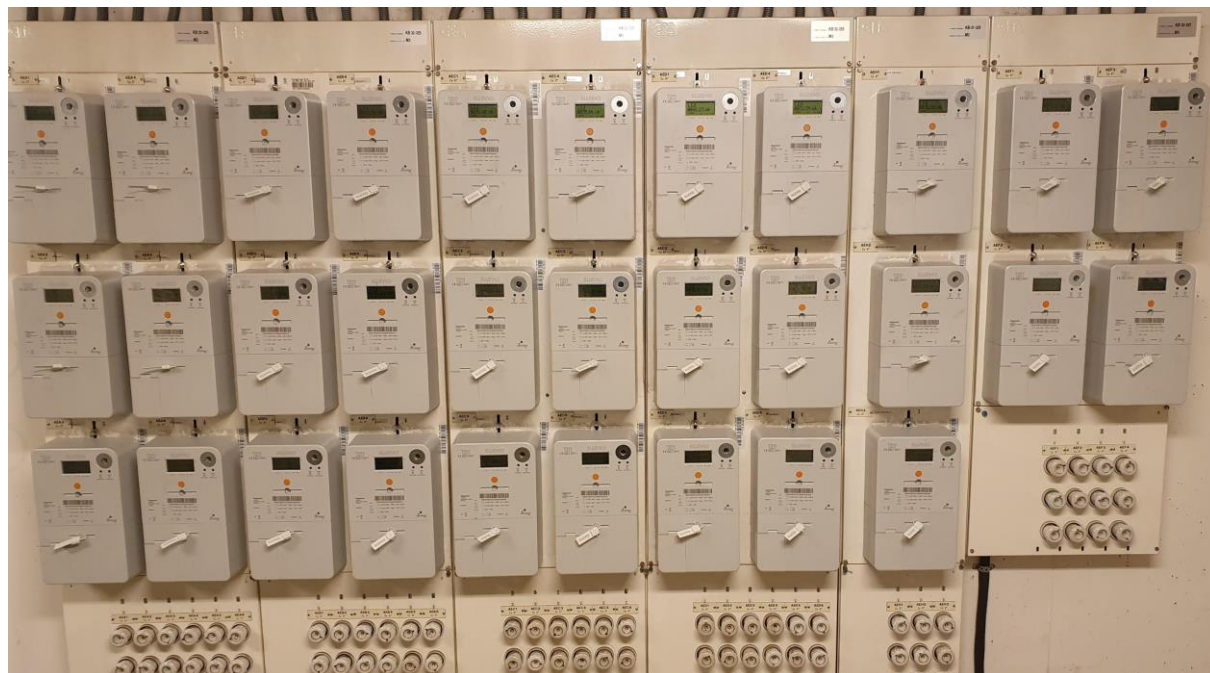
Figur 1. Exempel på elmätare till lägenheterna förlagda till utrymmen i källarna i respektive hus
