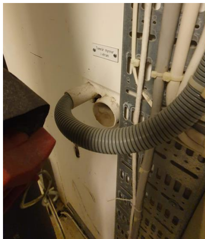
Figur 5. I fläktrum finns tomrör som mynnar i elrum enligt märkning.
